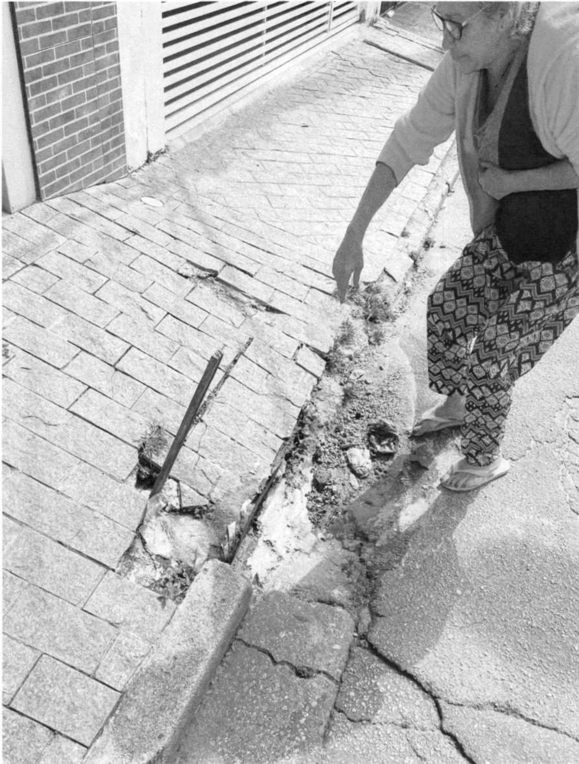
REPARO DA EROSÃO FORMADA NA RUA MARIO YOSHIDA EM FRENTE AO N° 36, VILA NOVA CINTRA – MOGI DAS CRUZES.p
